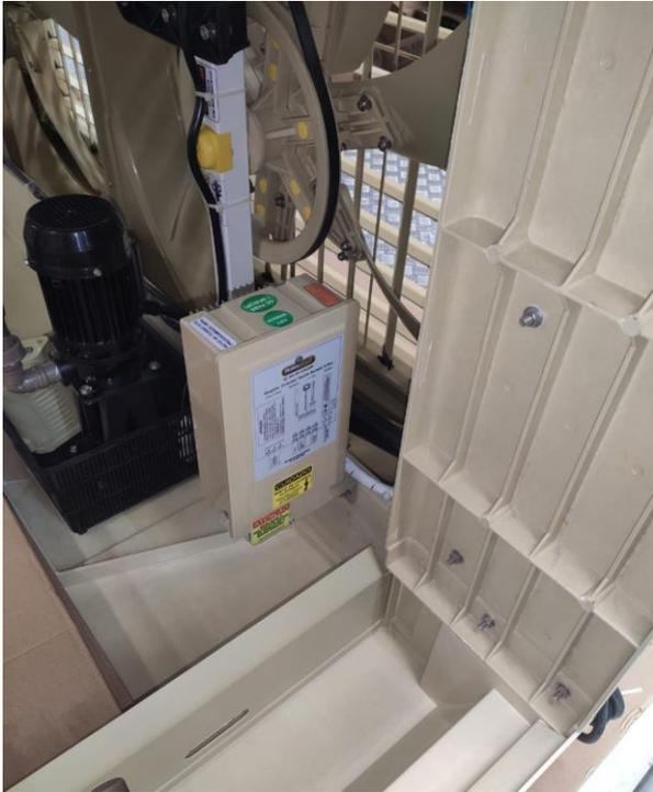
A imagem ao lado demonstra como o novo inversor deverá ficar acondicionado na parte interna do climatizador evaporativo.
