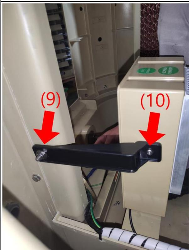
(9) Utilizar o parafuso, porca e arruela de  $\frac{1}{4}$ ", para fixar o reforço na lateral do climatizador. O resultado deve ser o da imagem ao lado, com o parafuso sextavado preso na lateral do climatizador (9) e o parafuso phillips preso na lateral do inversor de frequência (10).
