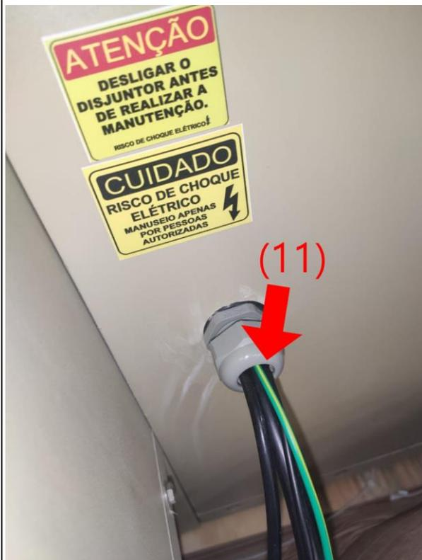
(11) Todos os cabos que interligavam o quadro Confort/Plus aos componentes internos do climatizador (motor principal, bomba de água, sensor de nível, descarte de água, dentre outros), deverão ser puxados para dentro do climatizador, através do prensa cabo, localizado na lateral esquerda. Todas essas derivações deverão ser conectadas ao inversor de frequência na parte interna do climatizador evaporativo.
