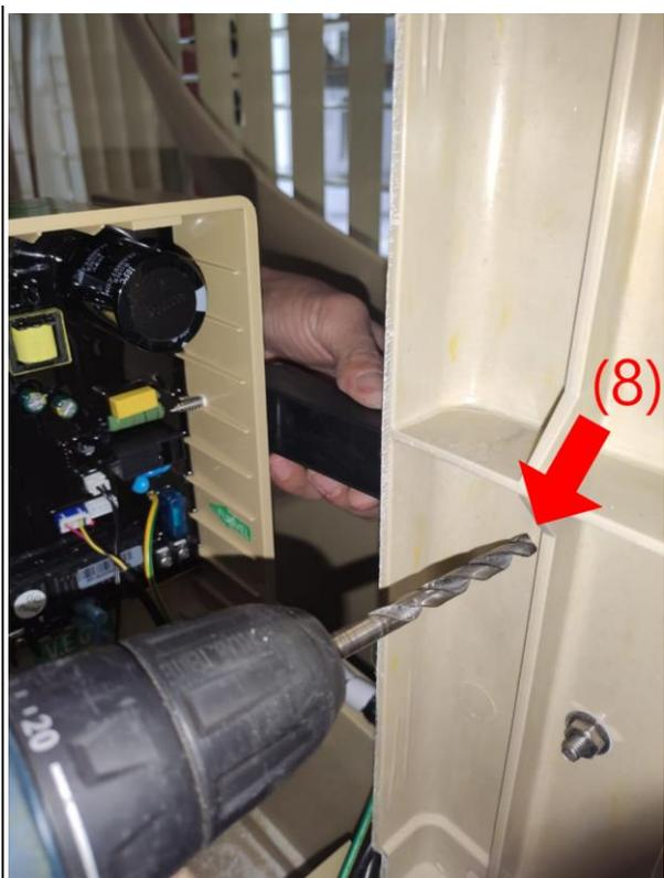
(8) Na parte interna da lateral do climatizador, deverá ser realizado um furo utilizando broca 7, com o objetivo de prender o reforço, anteriormente fixado ao inversor de frequência. Medir a distância, de acordo com o posicionamento do reforço, de modo que quando fixado, o inversor permaneça na posição mais vertical possível.
